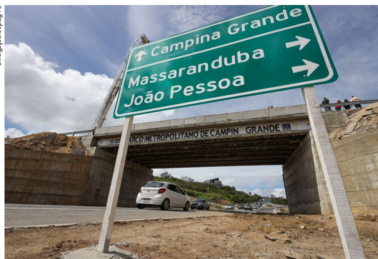
Arcos Metropolitanos é a solução de mobilidade que desvia o tráfego de veículos pesados das áreas centrais
