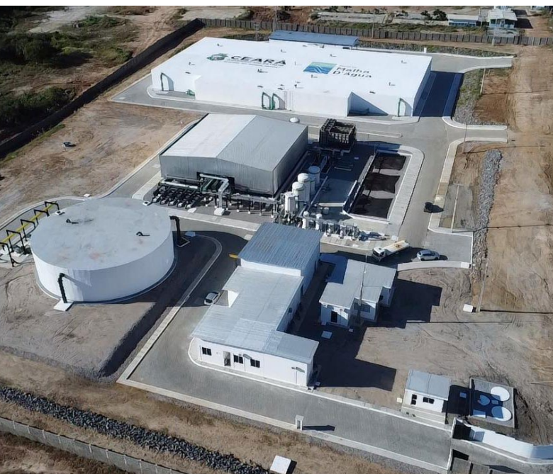
As estações de tratamento de água asseguram que a água já siga tratada para os núcleos urbanos integrados ao sistema
