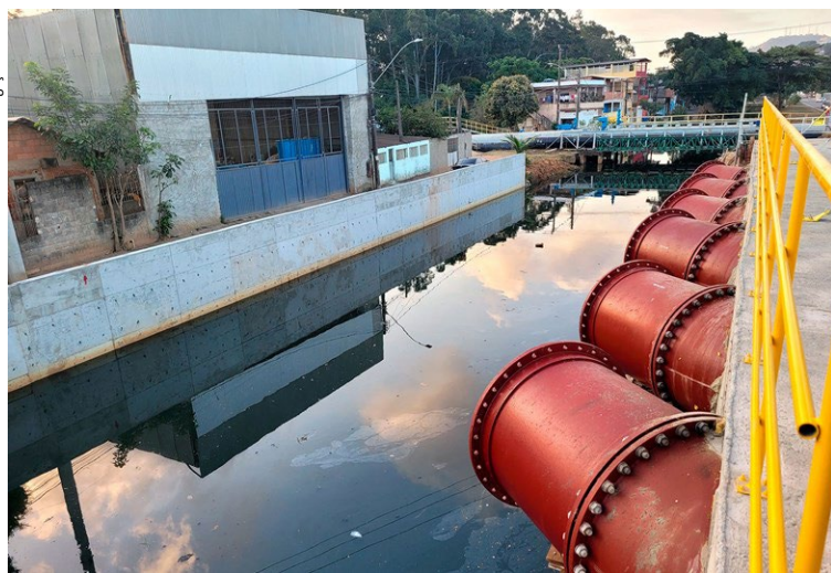
Obras de macrodrenagem em Vila Velha transformam desafios históricos em soluções concretas de dignidade, segurança e qualidade de vida para a população
