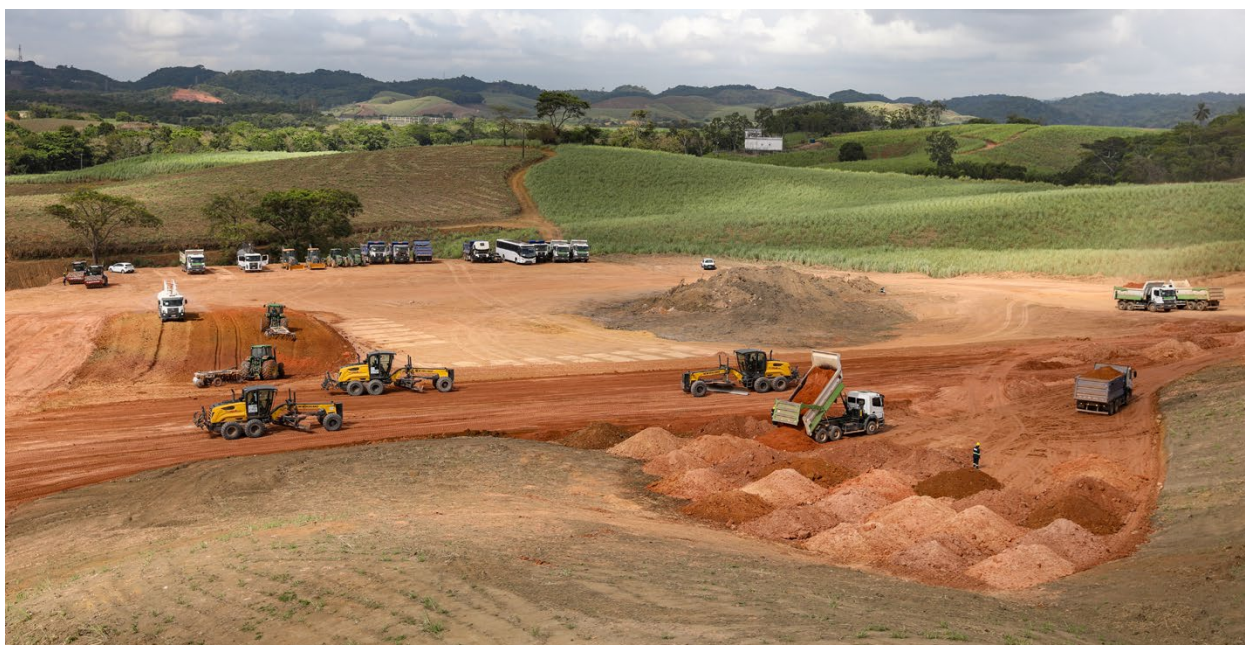
Obra do Arco Metropolitano
