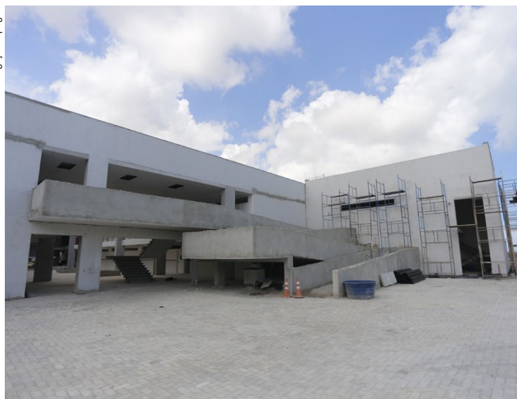
O governo do Ceará assumiu o compromisso de construir 138 novas escolas. Dessas, 15 já foram entregues e 103 estão em obras
