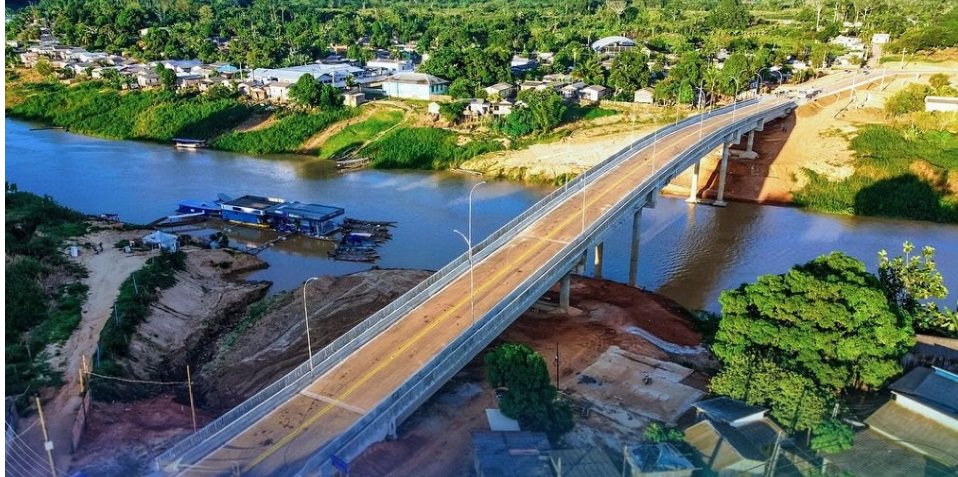
Foto: Ponte que liga o primeiro e o segundo distrito de Sena Madureira.
